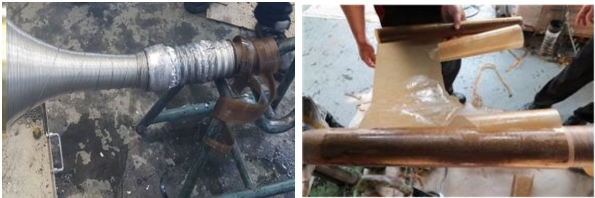
Рисунок 4. Демонтаж и осмотр кабелей.
